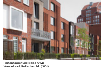
Ratherhäuser und kleine GWB Wandeloord, Rotterdam NL (DZH)
