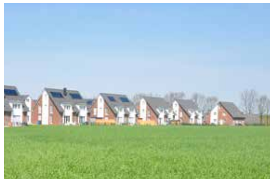
14. Bebauung Gerhard-Bachmann-Ring, Neu Wulmstorf
